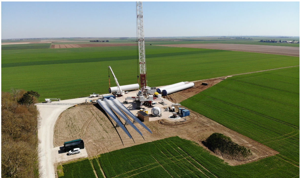
Phase d'assemblage : Parc éolien du Bois du Frou, ©JP Energie Environnement
